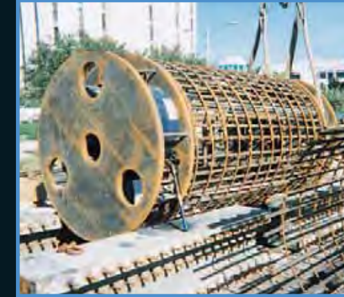
اختبار حمولة عالية بواسطة استعمال عدة خلايا أو - سل (O-cell)
